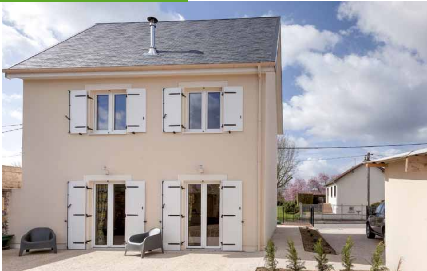
▲ La 1 ère maison en bois labellisée « Bepos-Effinergie ». Toiture en ardoise et enduit crème sur menuiserie blanche, la demeure affiche une esthétique sobre et joliment finie, avec ses gouttières discrètes et son conduit de cheminée tout inox.
